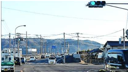
改善前：右折矢印信号機がないため、右折レーンに車両が停滞し、直進車両が進めない状況
